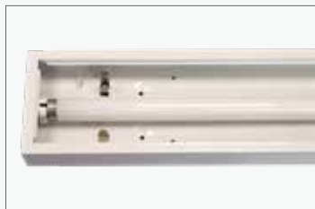
Schritt 1 bestehendes Leuchtmittel entfernen
